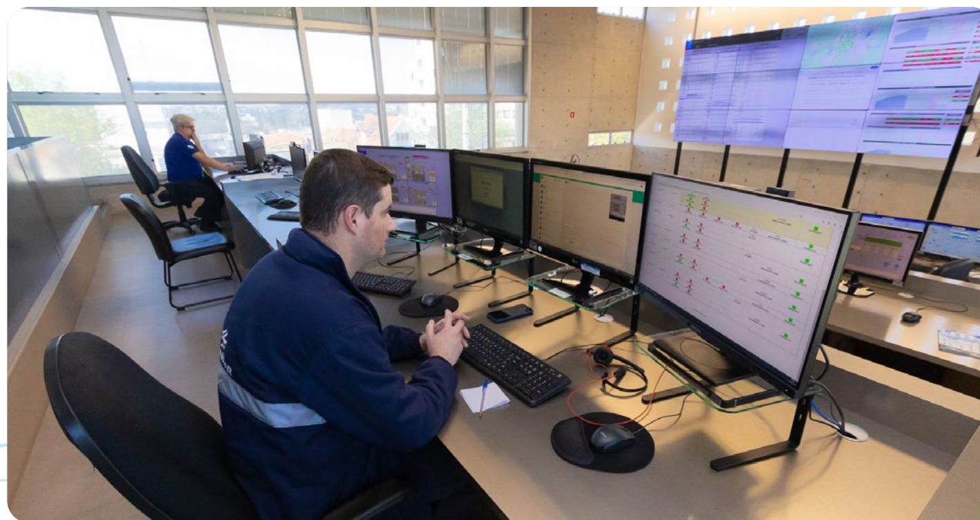
Centro de Controle Operacional em Curitiba - Fotógrafo: André Thiago Chaves Aguiar
