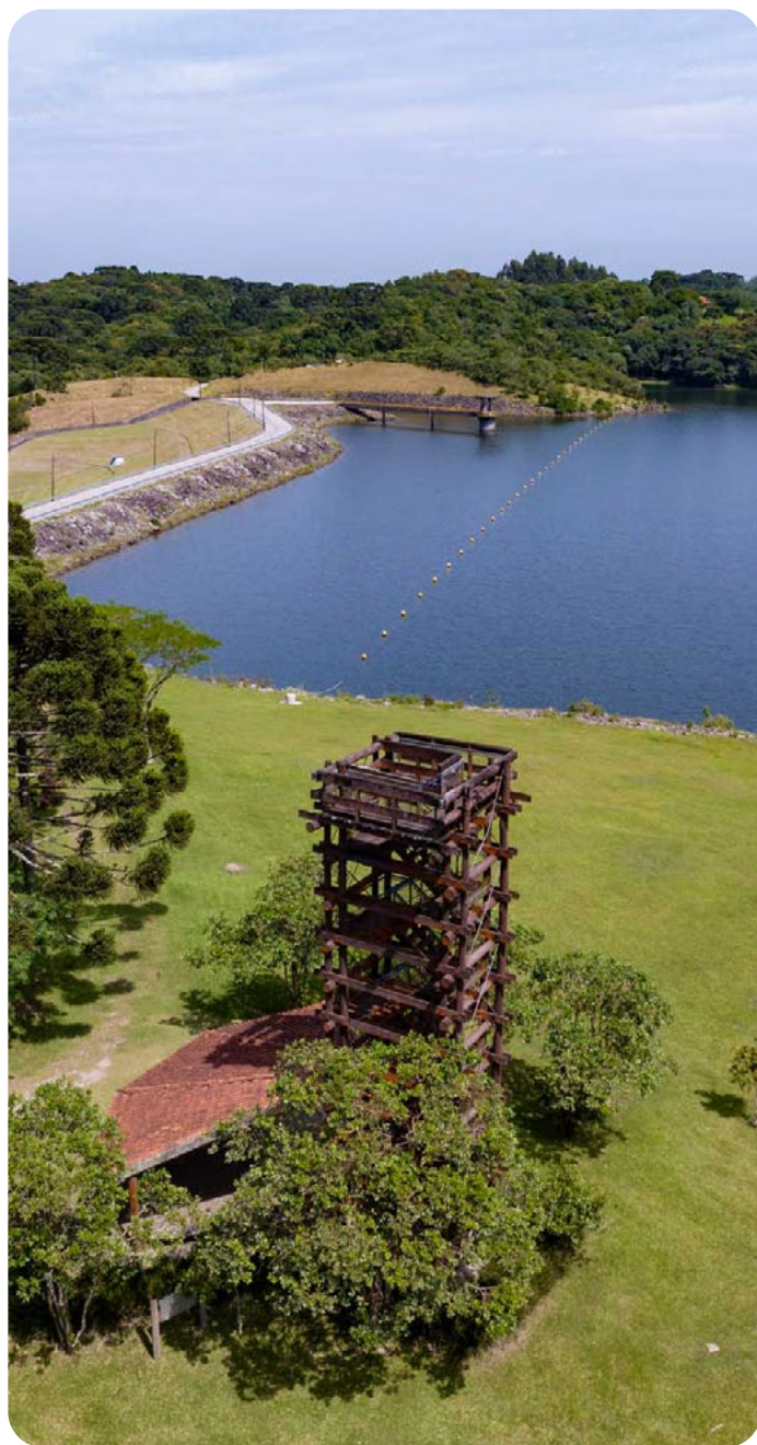
Mirante do Centro de Educação Ambiental na Barragem Piraquara 1 - Fotógrafo: André Thiago Chaves Aguiar
