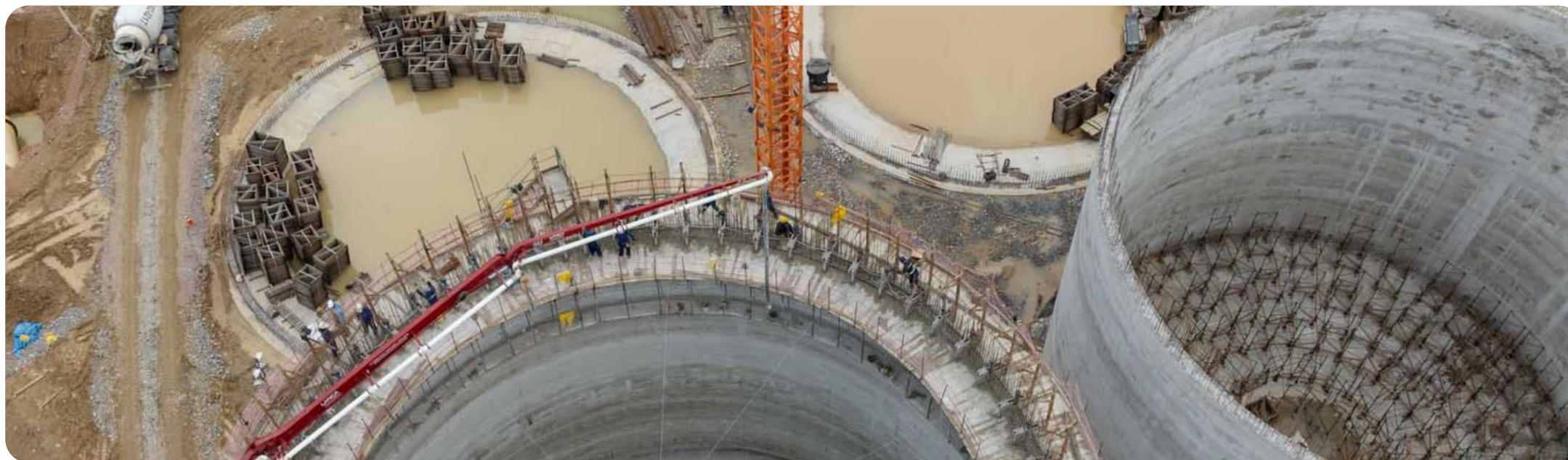
Obras ETE Atuba Sul - Fotógrafo: André Thiago Chaves Aguiar
