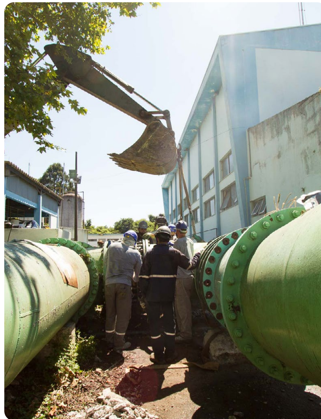
Obra Captação Iguaçu - Fotógrafo: André Thiago Chaves Aguiar
