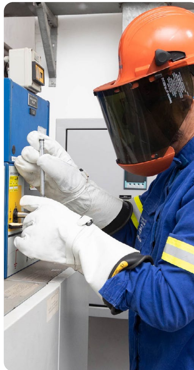
Sistema elétrico do Reservatório Corte Branco - Fotógrafo: André Thiago Chaves Aguiar
