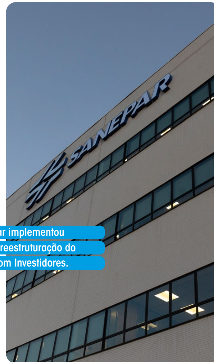
Novo Edifício Administrativo - Curitiba - Fotógrafo: André Thiago Chaves Aguiar
