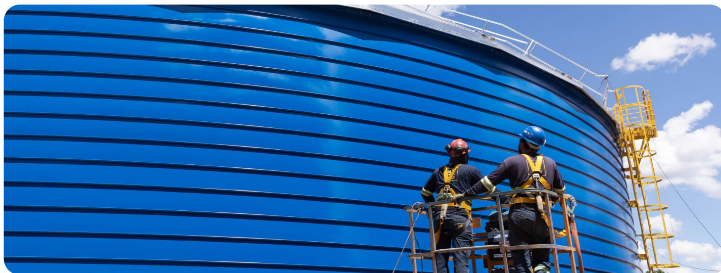
Tietê reservoir - Fazenda Rio Grande - Photographer: André Thiago Chaves Aguiar
