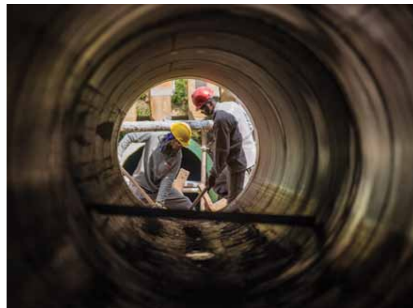
Obras na ETE Belém melhoram as condições operacionais da estação
