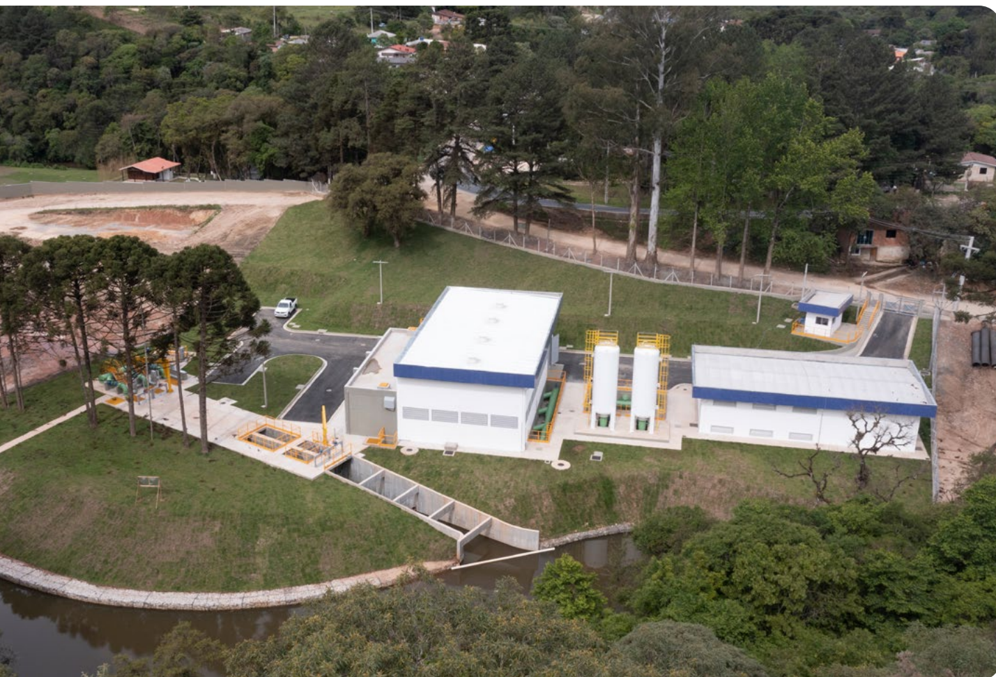
Estação de captação de água Capivari - Taramã. Autor: André Thiago Chaves Aguiar
