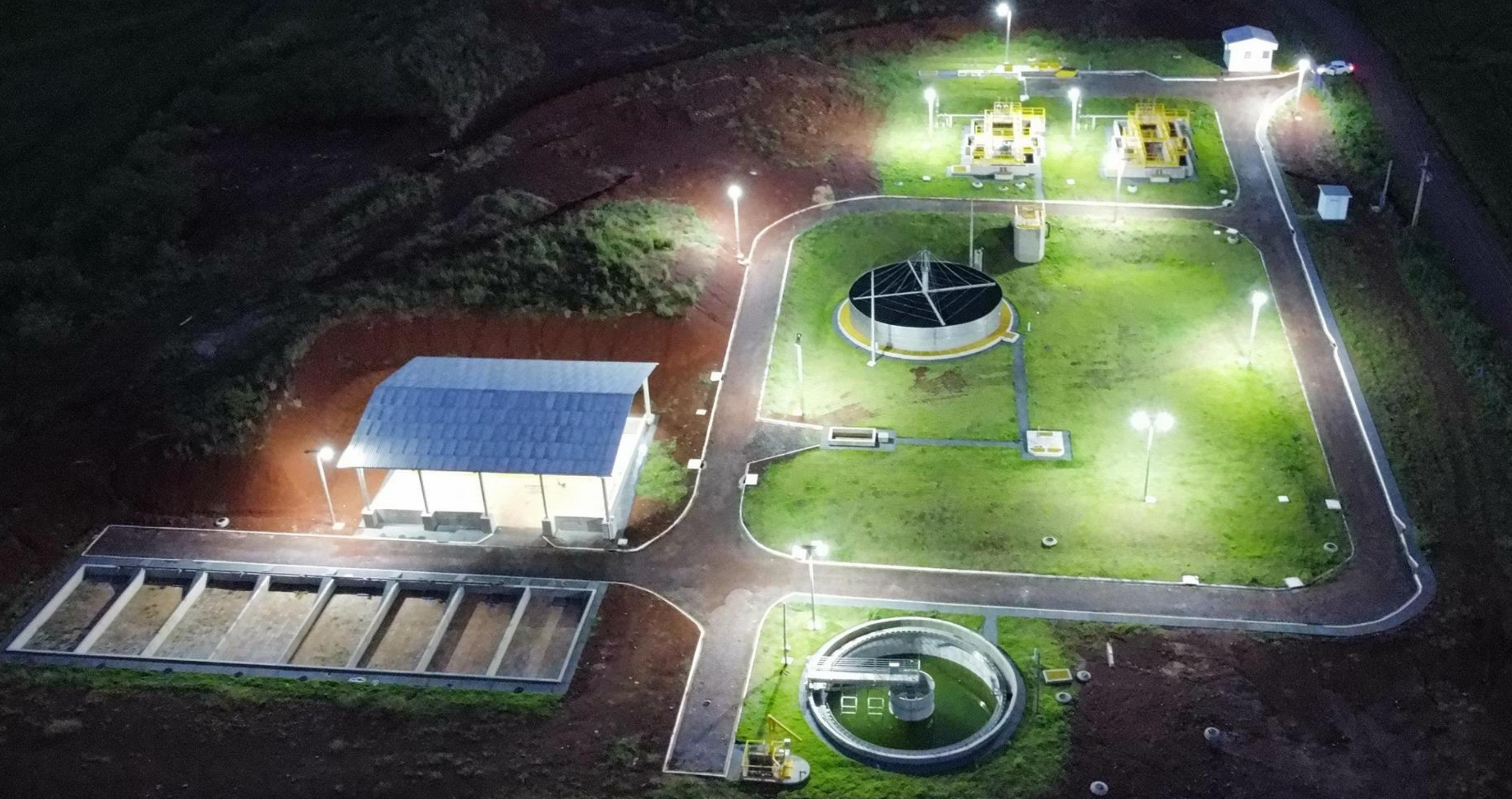
Estação Tratamento de Esgoto - Campina da Lagoa
